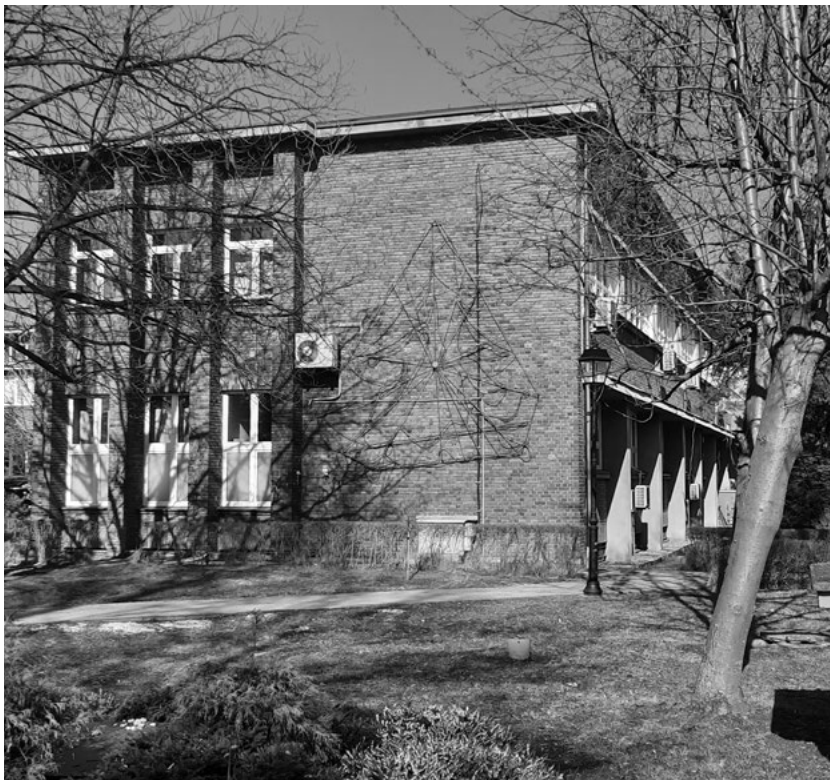
8.17.6. Budynek administracyjny kopani „Ziemowit” w Łędzinach, 2020 [fot. ze zbiorów autora]
