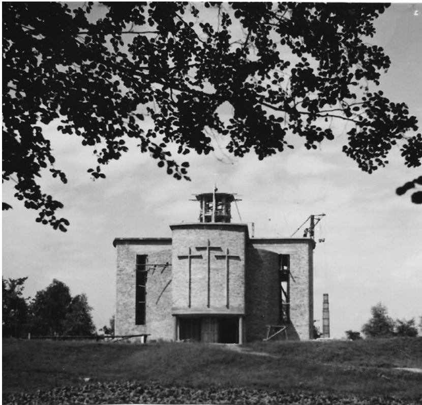
8.7.9. Tadeusz Brzoza, Jan Krug, Kalwaria w Panewnikach, stacja X, widok z czasu budowy, przed 1940 [ze zbiorów Jarosława Angermana]
