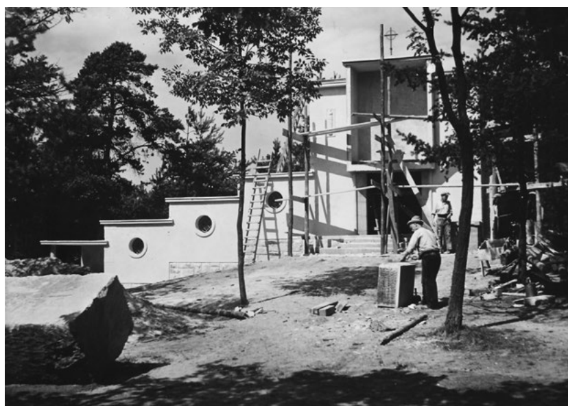
8.7.1. Tadeusz Brzoza, Jan Krug, Kalwaria w Panewnikach, stacja I w czasie budowy, przed 1940 [ze zbiorów Jarosława Angermana]
