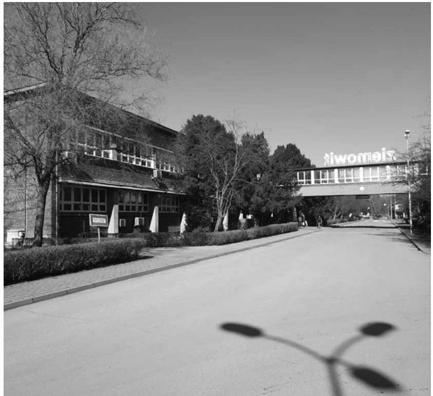
8.17.7. Budynek administracyjny kopani „Ziemowit” w Łędzinach, 2020 [fot. ze zbiorów autora]
