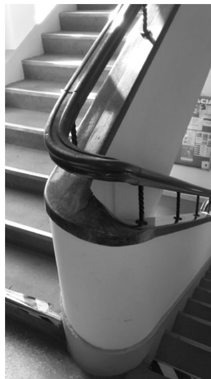
7.4.8. Balustrada schodów w dawnej Centrali Tekstylniej w Łodzi, 2020 [fot. ze zbiorów autora]
