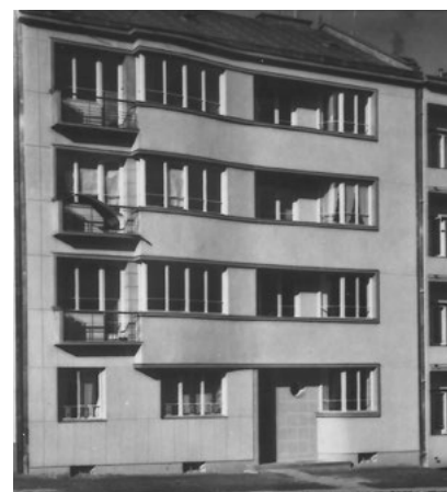
8.3.1. Jan Krug, Kamienica przy ul. Wuleckiej 32, elewacja frontowa, przed 1940 [fot. ze zbiorów Jarosława Angermana]
