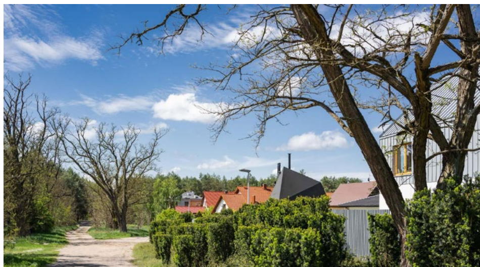
Il. 1 Origami House, architekci: Przemo Łukasik, Łukasz Zagala, Medusa Group, 2021. Fot. Juliusz Sokolowski, dzięki uprzejmości architektów.
