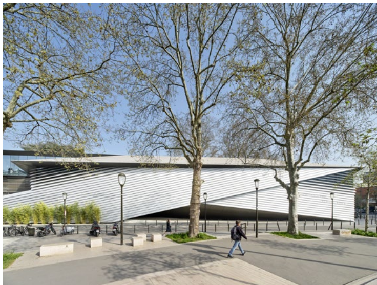
Il. 19. Pawilon Muzeum Alberta Kahna w Boulogne-Billancourt, proj. Kengo Kuma. Fot. Michel Denance, 2022 (dzięki uprzejmości Kengo Kuma and Associates Paris).
