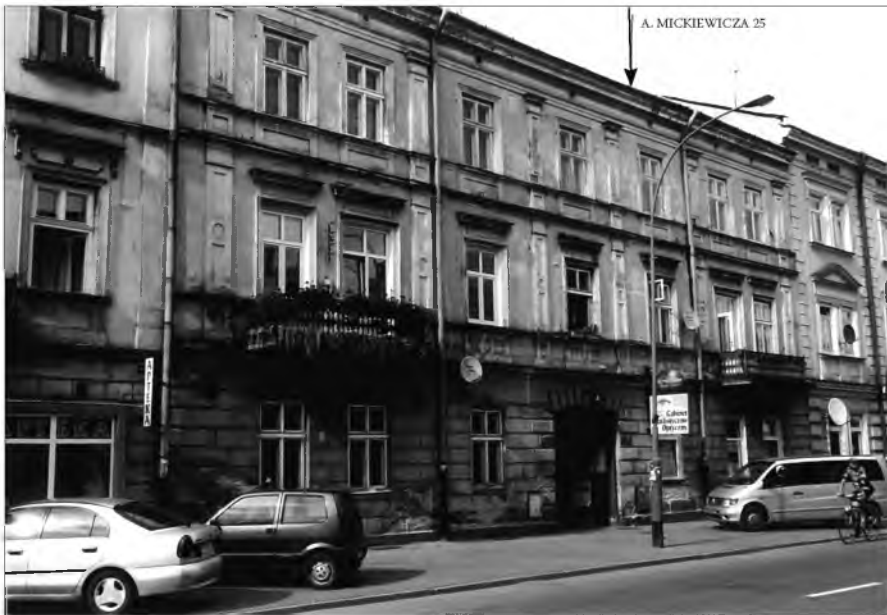
Rys. 5c. Kamienica przy ul. Mickiewicza 25, stan dzisiejszy; fot. aut.
