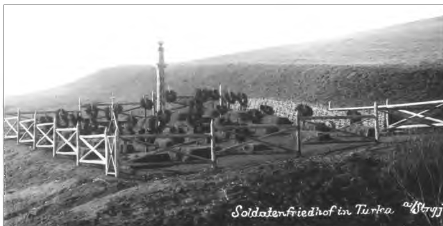
Rys. 16. Cmentarz wojskowy w miejscowości Turka (Okręg Stryj). Widoczne po prawej stronie w głębi ogrodzenie w formie plecionki. Autor nieznany; MNZP, MP. F 7001
