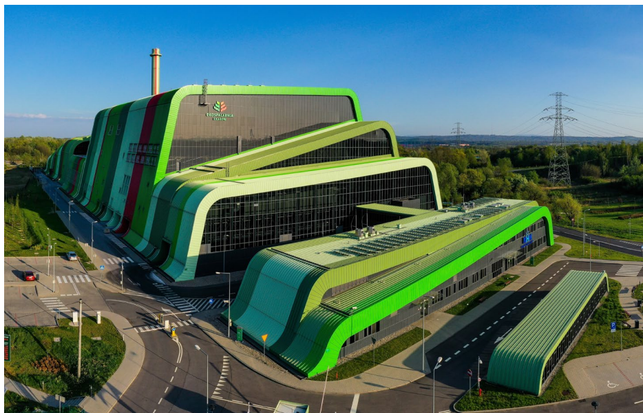
Zakład Termicznego Przekształcania Odpadów (Ekospalarnia Kraków), 2019
