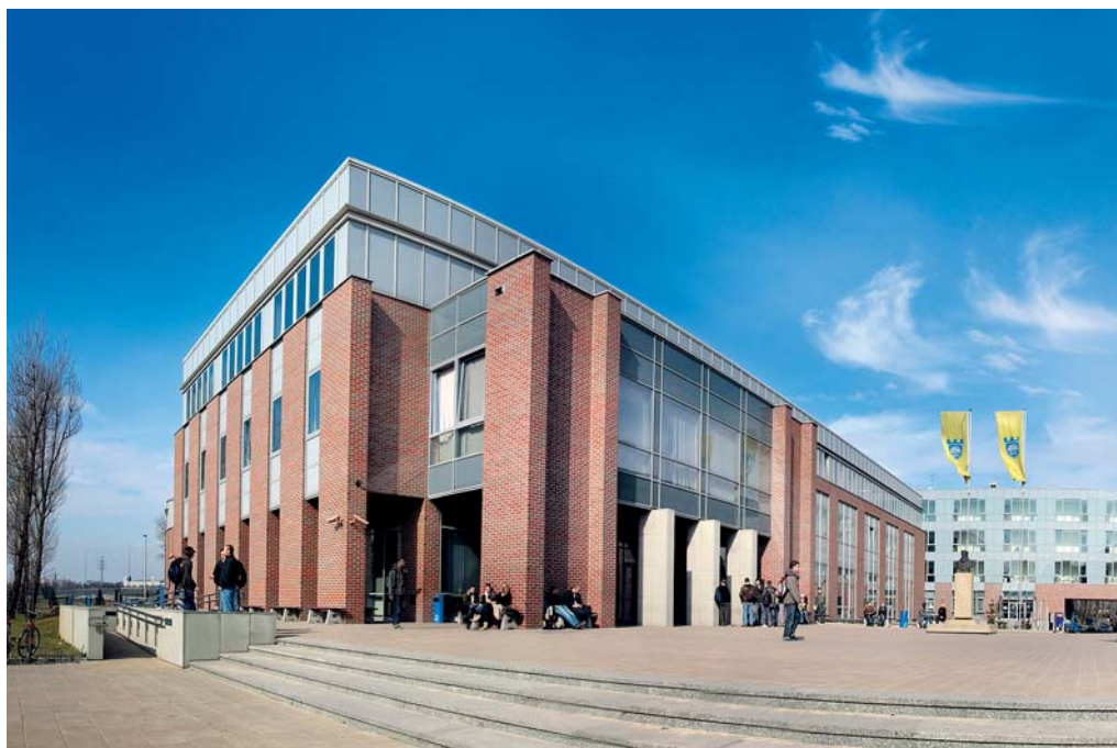
W 2005 r. został oddany do użytku budynek B (5462,84 m 2 ) wraz z aulą
