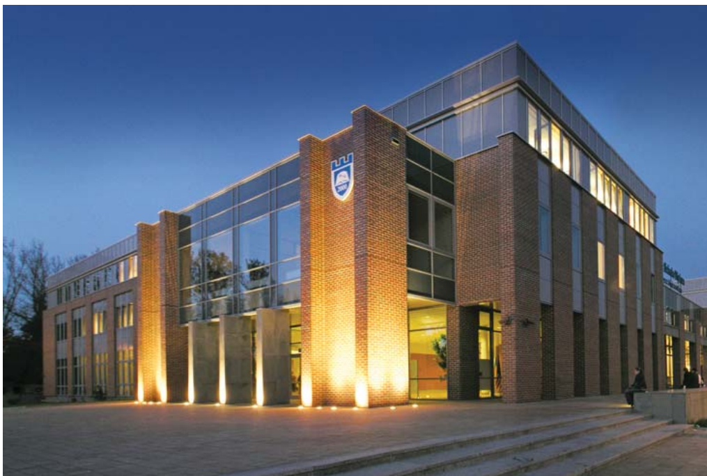
W październiku 2004 r. został oddany do użytku budynek A (10 784,7 m 2 )
