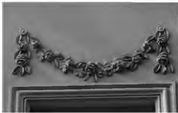
419. Kraków, pałac przy ul. Floriańskiej 28. Detal rzeźbiarski na fasadzie
