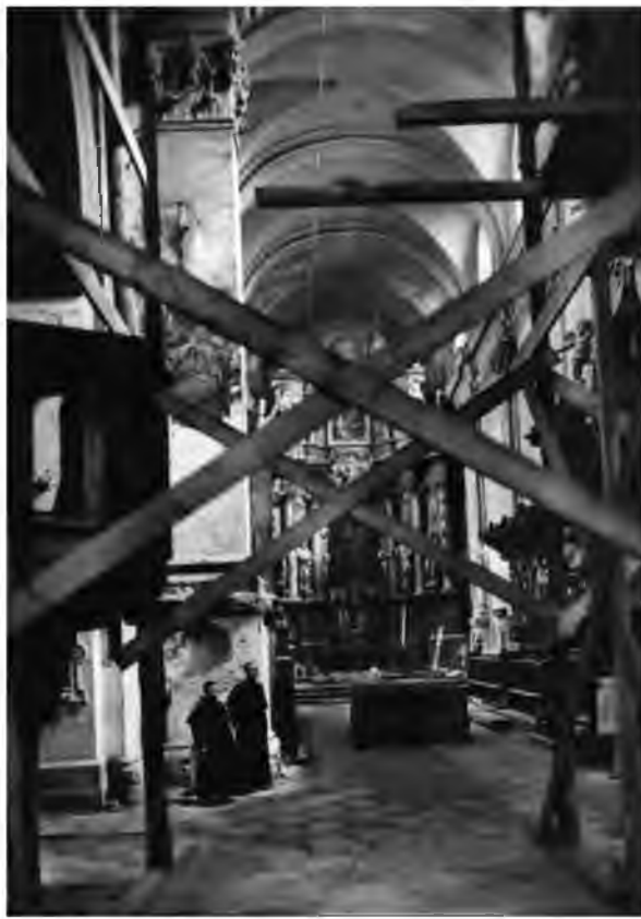
26. Kraków, kościół karmelitów na Piasku. Wnętrze prezbiterium w czasie remontu w latach 30. XX w.
