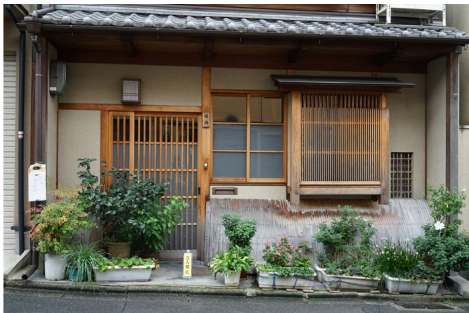
Ilustracja 2. Fasada odnowionej machiya , Kioto. Źródło: A building with a lot of plants in front of it , Unsplash, 5.11.2024, https://unsplash.com/photos/a-building-with-a-lot-of-plants-in-front-of-it-XO1wFnc1Dc [dostęp: 7.02.2025]. Fot. Yq Tian.
