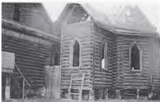
Pusty budynek kościoła w Wierszynie, po lewej widać boczną ścianę klubu, 1990 r. Fot. W.M.
