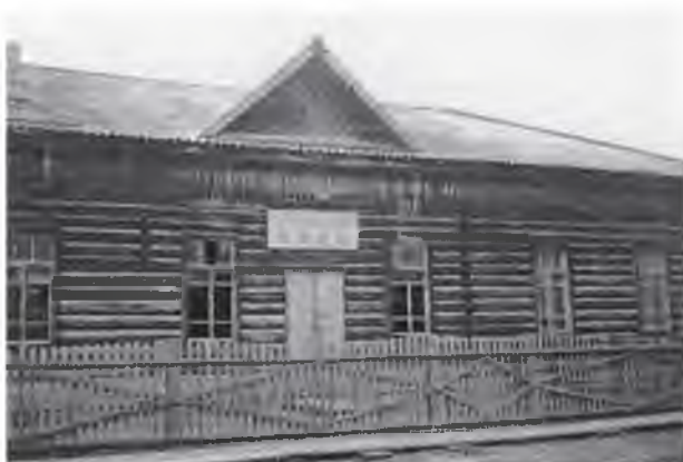
Budynek klubu, zastępujący od 1950 r. kościół od strony drogi, 1990 r. Fot. W.M.
