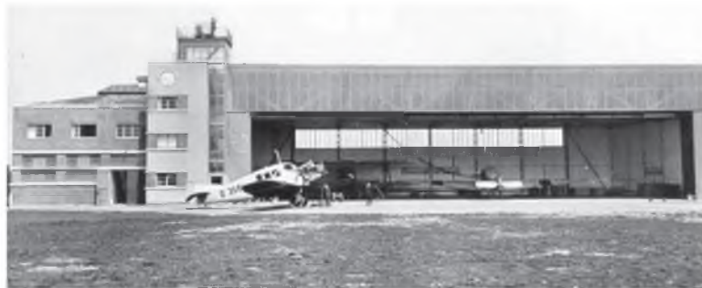
2.1-17. Zintegrowany hangar, budynek administracyjny, terminal i wieża kontroli. Lotnisko Dortmund-Brackel, 1927 r. Budynek niezachowany.
