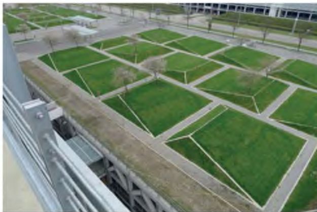
5.5-3. Widok na „zielony dach” garażu wielopoziomowego.
