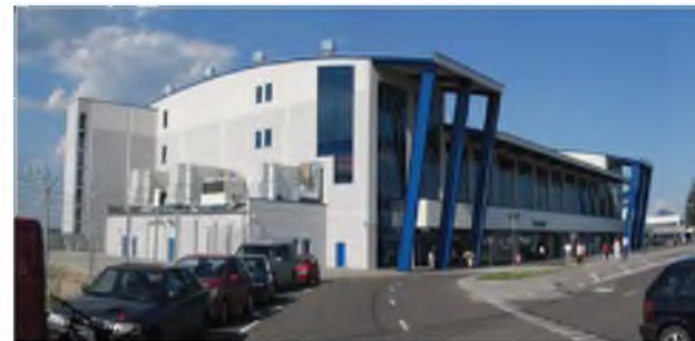
2.4-35. Terminal B. Widok od strony głównego podjazdu, 2007 r.
