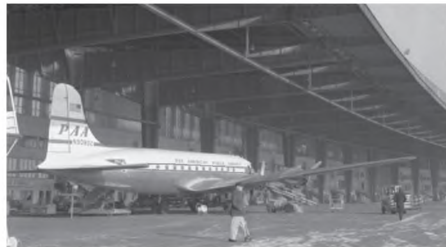
3.4-8. Tempelhof II, 1936. Daleko wysunięte wspornikowe zadaszennia ostnając ludzi i samoloty. Idea wykazująca cechy wspólne z zadaszenniami peronów kolejowych. Podobne rozwiązanie zastosowano w terminalu w Elmdon w Wielkiej Brytanii w roku 1939.
