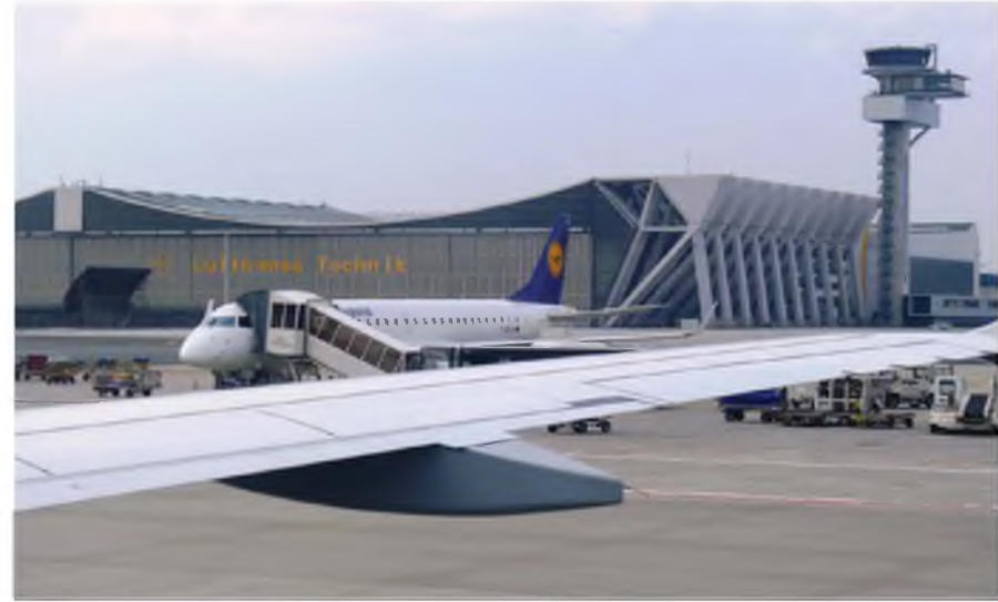
2.1-9. Hangar we Frankfurcie, projekt ABB Architekten, 1972 r. Mocno eksponowana ekspresja układu konstrukcji dachu wiszącego. Hangar mieści 6 samolotów B747 lub 14 B707.
