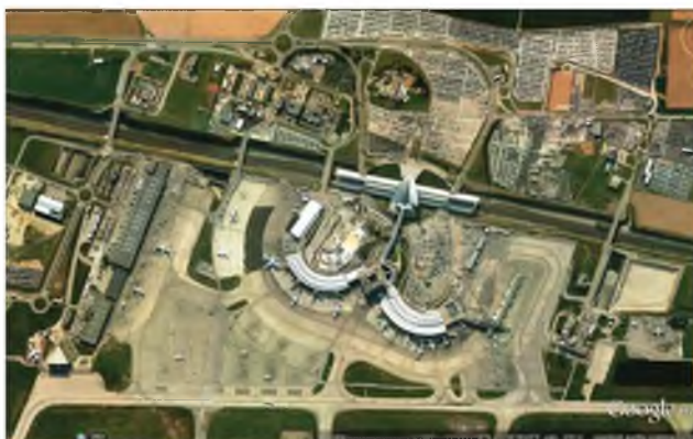
3.4-30. Port lotniczy Lyon-Saint-Exupéry, posiada stację kolejową, która umożliwia przesiadki na szybki pociąg TGV z Paryża do Marsylii. Wachlarzowaty kształt zbudowany w 1994 r. według projektu Santiaga Calatravy stał się emblematem miejsca.
