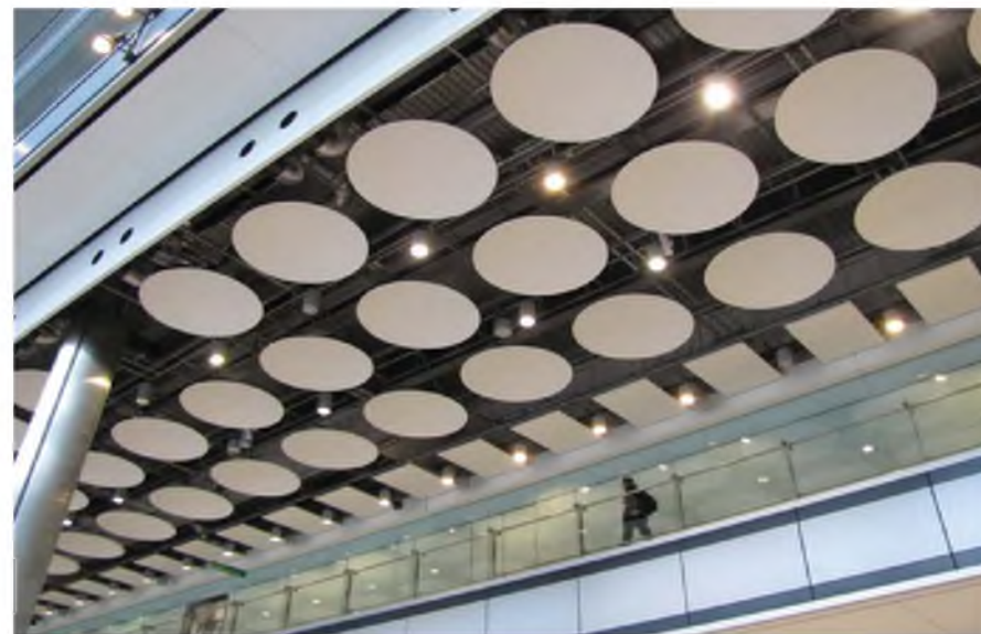
3.3-20. Terminal T5 na Heathrow. Sufit podwieszony tylko w części maskujący instalacje znajdujące się powyżej. Ta umowna bariera wzrokowa czyni zadość przeciętnemu poczuciu wykończenia płaszczyzny z jednej strony, z drugiej zaś rzadka i łatwo demontowalna umożliwia swobodny dostęp do instalacji podstropowych.
