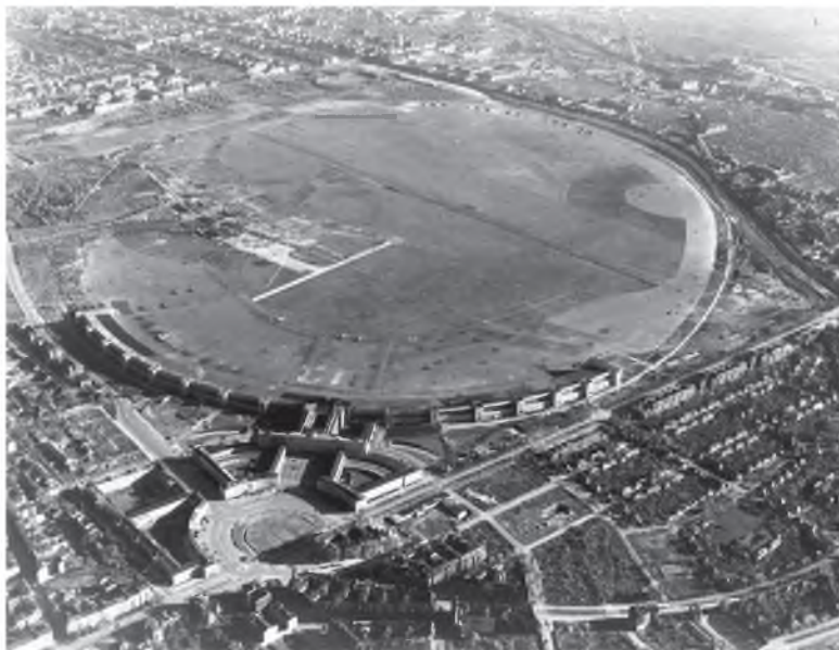
2.2-20. Tempelhof 2. Architekt Ernst Sagebiel. Widok ogólny, ok. 1948 r.
