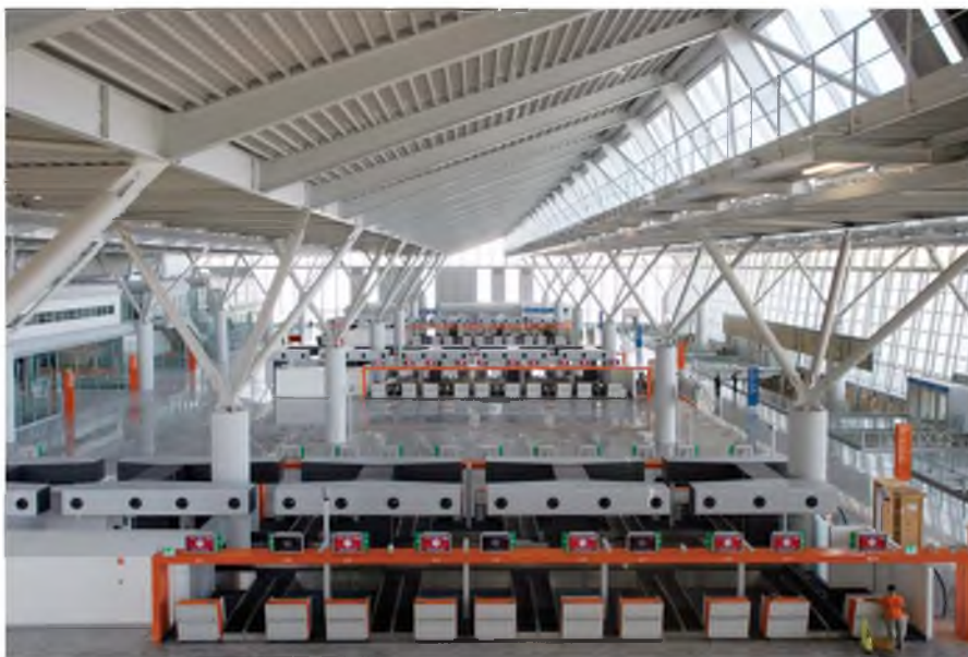
2.4-14. Warszawa-Okęcie, Terminal T2. Widok holu po stronie landside , stanowiska odprawy biletowo-bagażowej.
