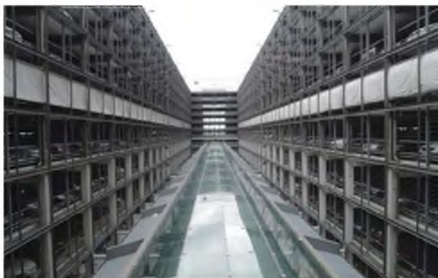
5.5-4. Pasaż wewnątrz garażu wielopoziomowego.
