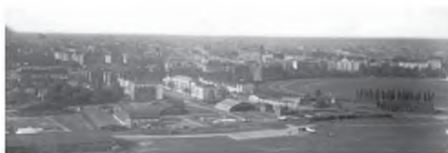
2.4-3. Port Lotniczy Warszawa-Mokotów. Na zdjęciu panoramicznym widać jak wysoka śródmiejska zabudowa napiera na tereny lotniska. Jego los zdawał się już wtedy przesądzony. Po prawej widoczny hipodrom, na którym odbywały się pierwsze loty statków powietrznych.
