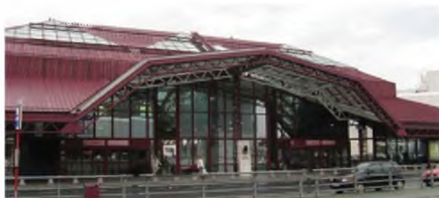
2.4-11. Warszawa-Okęcie, Terminal T1. Widok ogólny od strony podjazdu.
