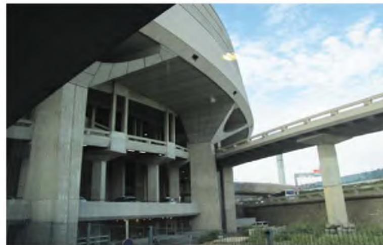
3.3-7. Terminal 1, port lotniczy Paryż-Roissy. Monolityczna konstrukcja żelbetowa nadaje monumentalny wyraz całemu założeniu – owalnemu terminalowi wraz z estakadami i satelitami.
