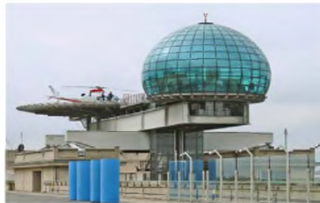
6.3-2. Renzo Piano, Lądowisko helikopterów i Bubble – sala konferencyjna pod szklaną kopułą, miejsce spotkań dla 24 uczestników, członków zarządu koncernu Fiata, zbudowana ponad dachem fabryki Fiata Lingotto w Turynie, 1995.
