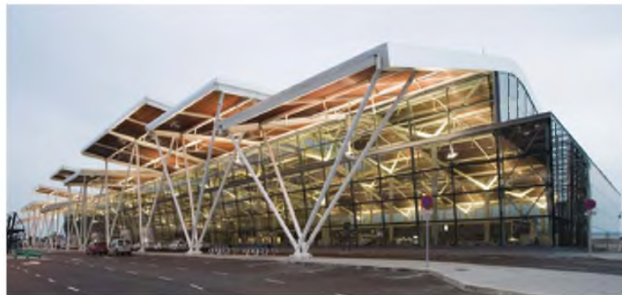
4.3-12. Terminal na lotnisku w Saragossie, Vidal + Asociados arquitectos, 2008. Widok od strony głównego podjazdu. Niedrogie materiały, stosunkowo prosta konstrukcja stalowa i blacha trapezowa, dzięki odpowiednim zabiegom formalnym pozwoliły uzyskać atrakcyjną formę. „Pływający” dach ma kojarzyć się z falami wody. W 2008 r. w Saragossie odbywała się wystawa Expo pod hasłem „Woda a zrównoważony rozwój” a terminal był częścią infrastruktury komunikacyjnej, która powstała specjalnie na tę okazję.
