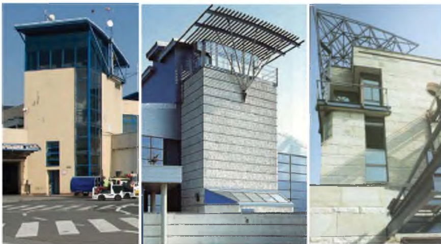
2.4-1. Wieże w terminalach czwartej generacji. Od lewej: terminal we Wrocławiu-Strachowicach, Gdańsku-Rębiechowie i Krakowie-Balicach.
