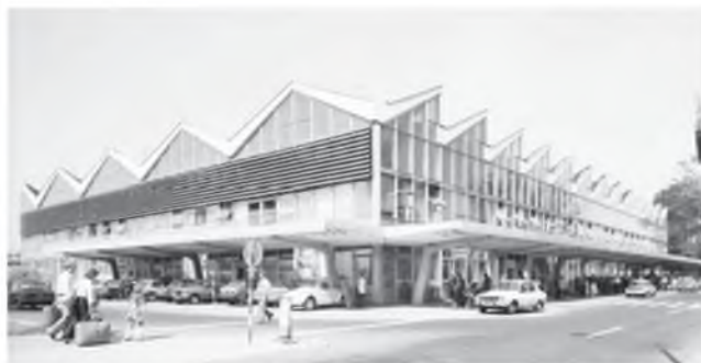
2.4-9. Port Lotniczy Warszawa-Okęcie, terminal pasażerski. Widok od strony głównego podjazdu. Budynek nieistniejący.
