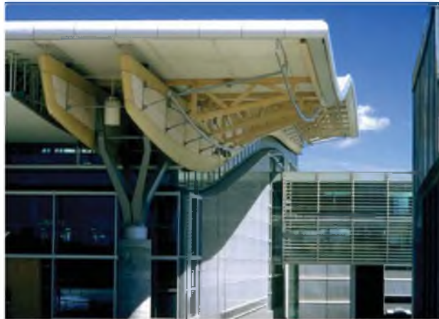
3.3-9. Terminal w Gardemoen pod Oslo. Drewniane dźwigary dachowe niesione przez stalowe głowice żelbetowych słupów.
