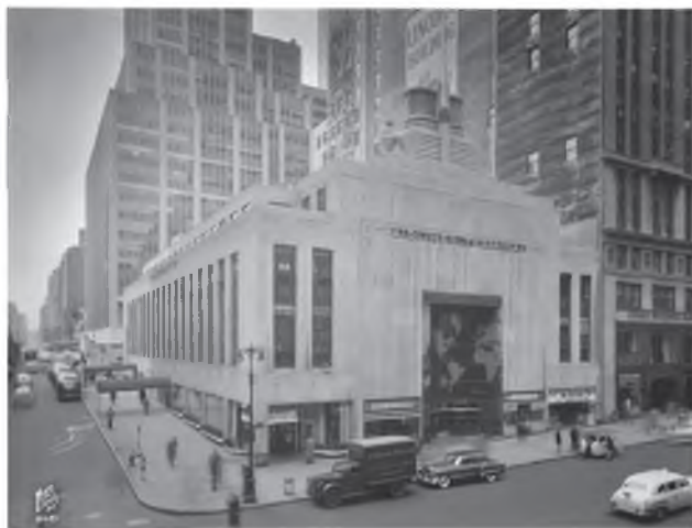
2.3-12. New York City, Airlines Terminal, 1940. Budynek nieistnieje.
