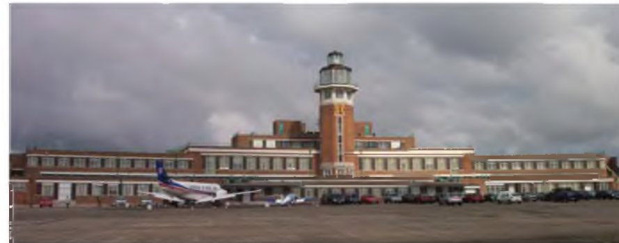
2.2-13. Liverpool-Speke, 1938. Projektant Albert D. Jenkins. Widok ogólny od strony płyty postojowej.
