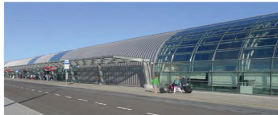
2.4-17. Mazowiecki Port Lotniczy Warszawa Modlin, 2012. Widok ogólny od strony podjazdu.
