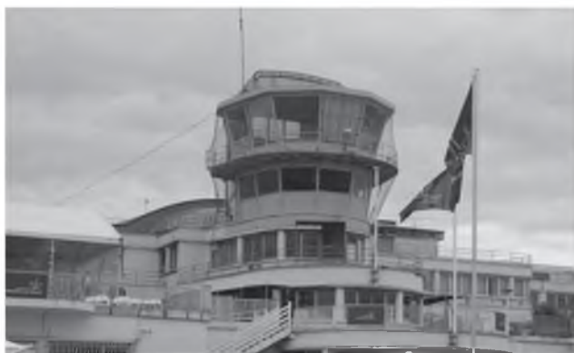
2.2-15. Paryż-Le Bourget 2, 1937. Widok od strony airside . Obecnie siedziba Muzeum Lotnictwa i Aeronautyki. Wieża kontroli po późniejszych przebudowach. Stan obecny.
