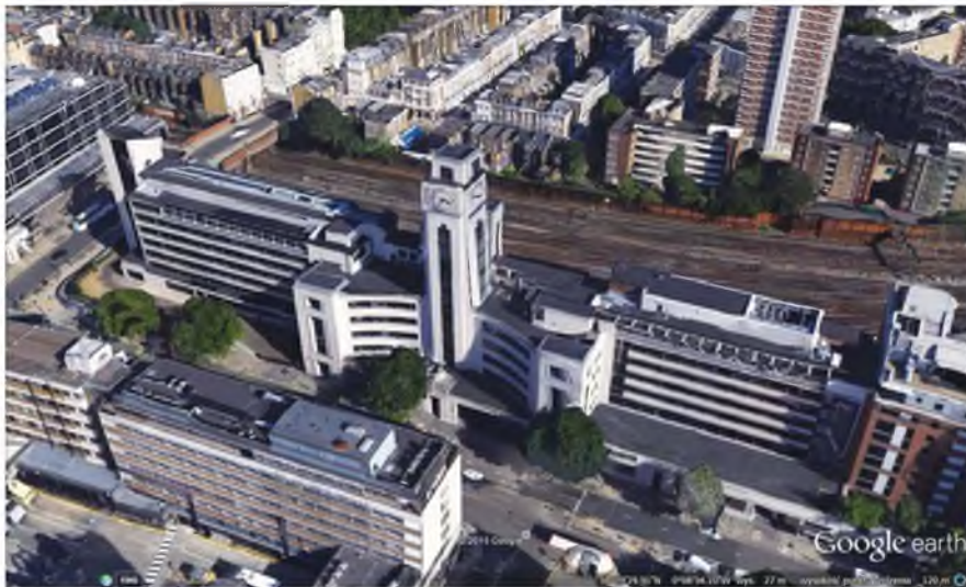
2.2-12. Londyn-Terminal Imperial Airways, 1938. Architekt Albert Lakeman. Stan obecny.
