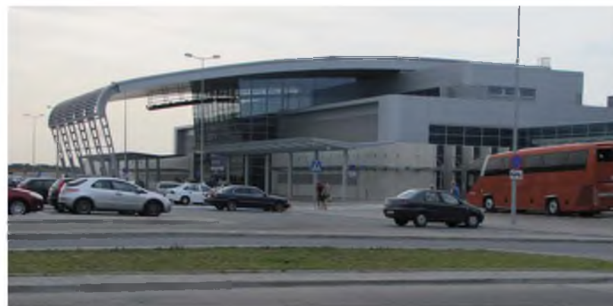
2.4-24. Widok ogólny nowej części terminalu, 2012.
