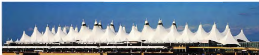
3.3-11. Lotnisko w Denver. Horst Berger Partners, Severund Ass., 1994 r.
