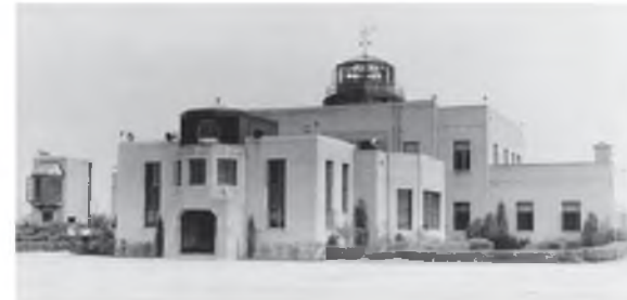
2.1-14. Cleveland Municipal Airport, USA, 1937 r., stanowisko obserwacji umieszczone na dachu budynku.
