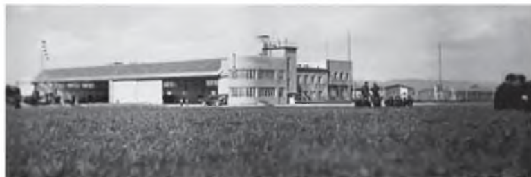
2.1-18. Lotnisko w Krośnicach, ok. 1939 r. Hangar i budynek obsługi lotniska. Budynek zachowany.
