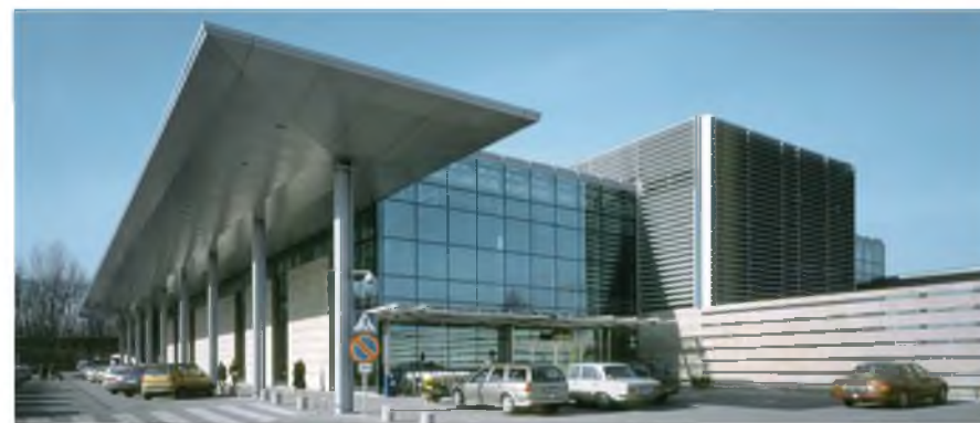
2.4-41. Kraków-Balice. Terminal pasażerski T2, 2001.
