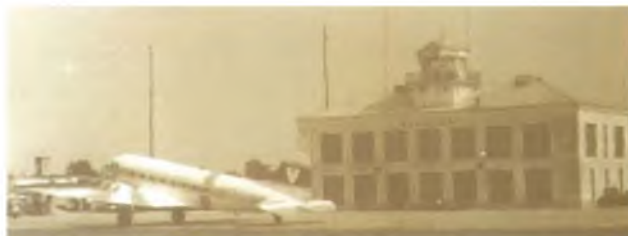
2.4-42. Dworzec pasażerski lotniska Rzeszów-Jasionka w latach 60. Obiekt reprezentuje wczesną fazę rozwoju terminalu lotniczego, łączącego funkcje recepcyjne dla podróżnych, siedzibę zarządu lotniska i wieżę kontroli, która swoją charakterystyczną formą określa funkcję budynku. Terminal wraz z wieżą został zachowany i po przebudowie pełni funkcję Ośrodka Kształcenia Lotniczego.
