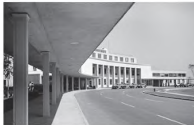
2.3-15. Washington National Airport, 1941. Architekci Howard Lovewell Cheney i Charles M. Goldman. Widok od strony podjazdu.
