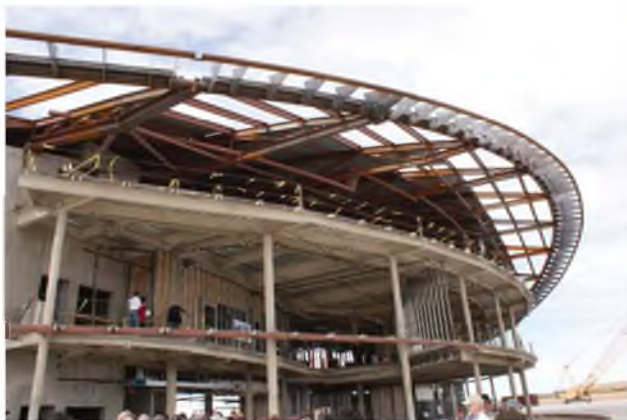
7.1-4. Hangar-terminal kosmodromu Spaceport America, w trakcie budowy. Foster + Partners, 2011. konwencjonalne i proste środki techniczne w budownictwie są ciągle jeszcze używane do kreowania form mających zwiastować nadejście nowej ery w technice lotniczej.
