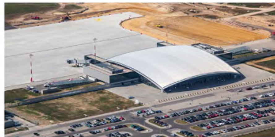
4.3-1. Rzeszów-Jasionka, APA Czech_Duliński_Wróbel, 2012. Płaszczyzna jednorodnego dachu stanowi najważniejszy dla architektury budynku terminalu element formalny. Jego geometria nasuwa skojarzenia ze spadochronem i lotnią, natomiast łuk wyprofilowany nad głównym wejściem może być interpretowany jako odwołanie do architektury elewacji frontowych budynków dworcowych.
