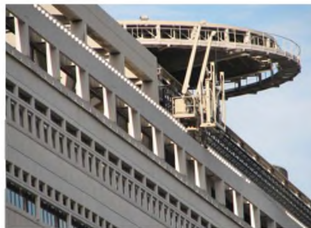
6.3-3. Ministerstwo finansów w Paryżu, Paul Chemetov, 1989. Heliport na dachu i marina w jednym budynku są spełnieniem marzenia futurystów o intermodalnej komunikacji centrów zarządzania znajdujących się w metropoliach przyszłości.
