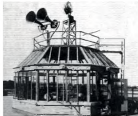
2.1-12. Stanowisko kontroli lotów zbudowane na hangarze w Wayne County Airport, USA. Początkowa faza funkcjonalnego i formalnego wyodrębniania się wieży kontroli.
