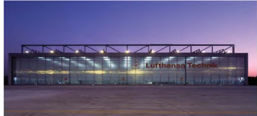
2.1-10. „Hangar A380” we Frankfurcie, projekt GMP Architekten von Gerkan, Marg und Partner, konstrukcja Schlaich Bergmann und Partner, 2007 r. Konstrukcja i środki wyrazu architektonicznego zredukowane do minimum. Hangar mieści 4 samoloty A380 lub 6 B747.
