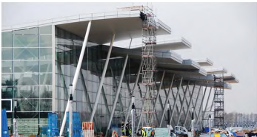
4.3-14. Wrocław, JSK Architekci, 2012. Widok od strony landside . Podobna jak w Saragossie zasada rozwiązania przekrycia dachu pozwala na osłanianie stref funkcjonalnych i doświetlenie wnętrza. Bogata struktura pozwala na osiągnięcie atrakcyjnej formy przestrzennej.
