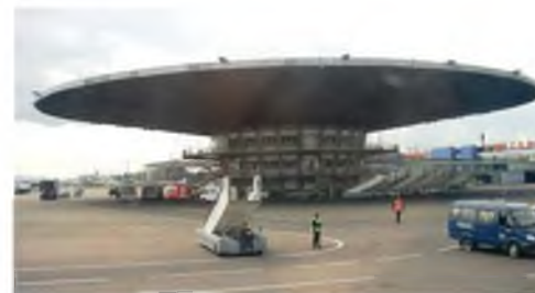
3.4-20. Na moskiewskim Szeremietiewie w 1964 roku otwarto Terminal I (obecnie Terminal B). Jest to centralny, zaprojektowany na planie koła o średnicy ok. 90 m budynek, o wielkim zadaszeniu osłaniającym operacje załadunku i rozładunku samolotów. Trudno oprzeć się wrażeniu, że jest to radziecka odpowiedź na nowojorski Worldport.
