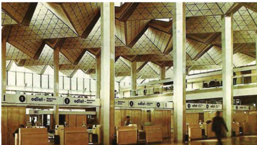
4.3-15. Warszawa-Okęcie, Krystyna Król-Dobrowolska, Jan Dobrowolski, 1969. Bogata rzeźba dachu przekrywająca jednoprzestrzenną wielką szopę była przedmiotem zainteresowania architektów już w latach 60. Śmiałe konstrukcyjne rozwiązania są zwykle ryzykowne pod względem użytkowym, gdyż wymagają dyscypliny projektowej i wysokiego poziomu techniki budowlanej.
