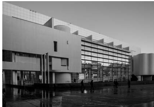
Il. 6. Muzeum Sztuki Współczesnej, proj. Richard Meier. Przykład wprowadzenia do zabytkowego centrum zarówno nowej funkcji, jak i formy architektonicznej. Wraz z dawnym klasztorem na ilustracji obok stanowią ściany ważnego społecznie i kulturowo placu, 2017 r.; fot. autor
